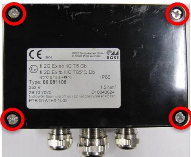
Abbildung 22: Deckel des Ex-Anschlusskastens
